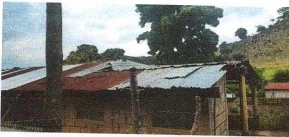
FOTO No. 3 Techo de los Baños
