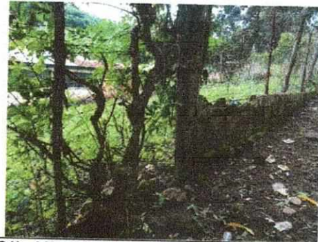
FOTO No. 2 Muro Perimetral
