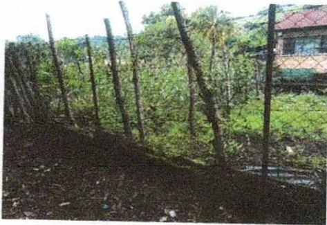
FOTO No. 1 Muro Perimetral
