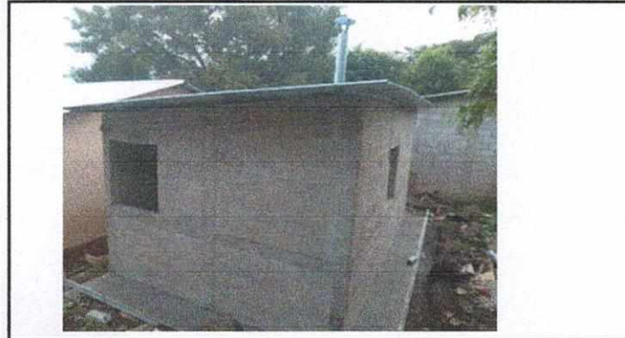
FOTO No. 01 INSTALACION DE TECHO EN COCINA
