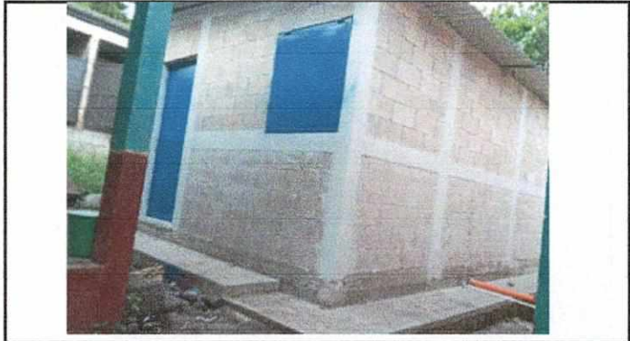
FOTO No. 02 INSTALACION DE VENTANAS Y PUERTAS EN COCINA
