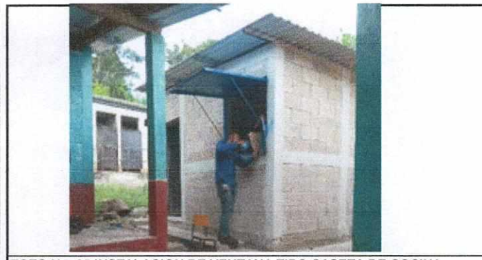
FOTO No. 05 INSTALACION DE VENTANA TIPO CASETA DE COCINA
