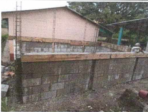
FOTO No. 01 SUSTITUCION DE PAREDES DE COCINA
