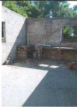
FOTO No. 02 INSTALACION DE PLANCHA PARA COCINA
