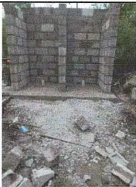
FOTO No. 03 SUSTITUCION DE PAREDES PARA BAÑOS
