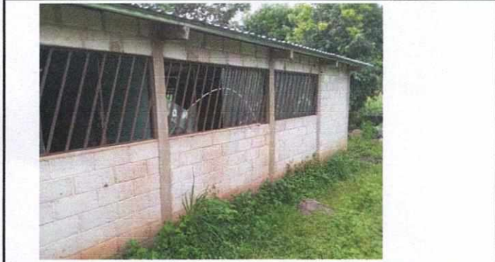
FOTO No.01 Cambio de ventanales
