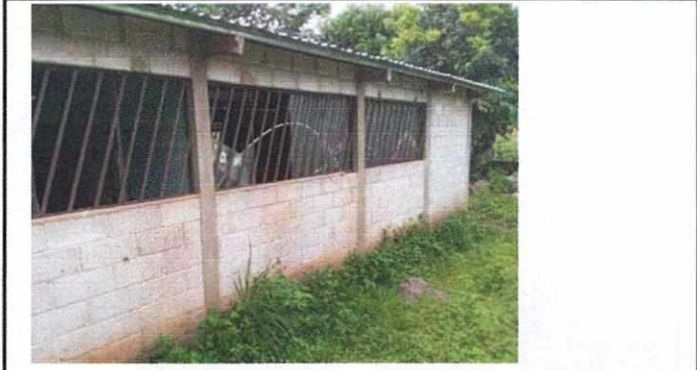
FOTO No. 02 Instalacion de balcones
