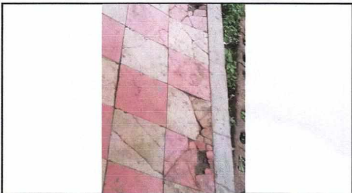
FOTO No.04 Sustitucion de piso
