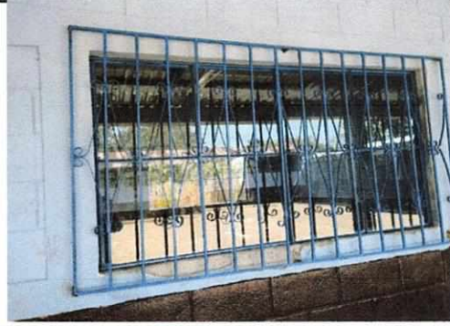
Foto 4: Colocacion de ventanas y restauracion de Balcones.
