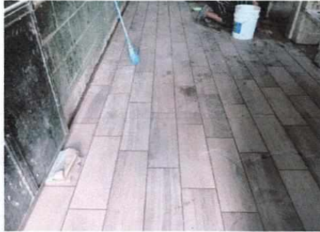
Foto 1 :colocacion de piso en cocina
