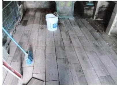
Foto 2: colocacion de iso en cocina
