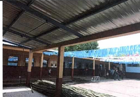
foto 6: colocación de Lamina Nueva.
