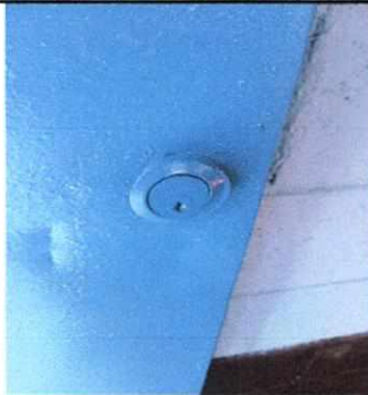
Foto 3: pintura y colocacion de chapas en puertas
