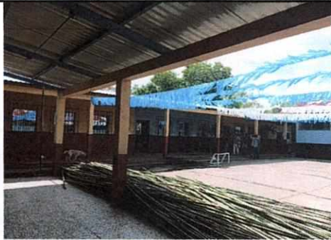
Foto 5: restauracion de estructura metalica.
