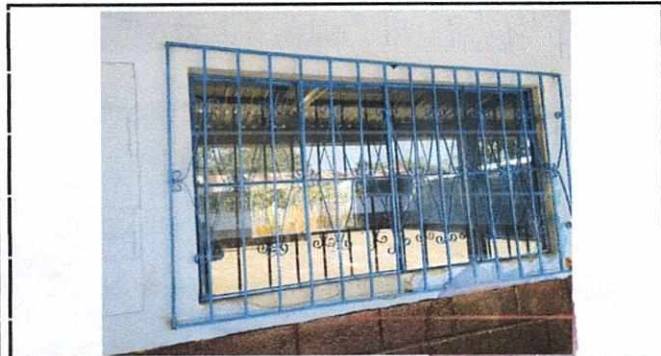
Foto 3: Restauración de Balcones y Colocación de Ventanas
