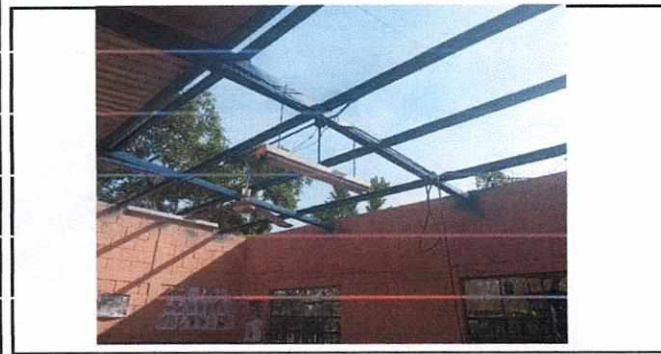
Foto 5: Colocación de Estructura Metalica
