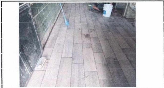
Foto 1: Colocación de Piso
