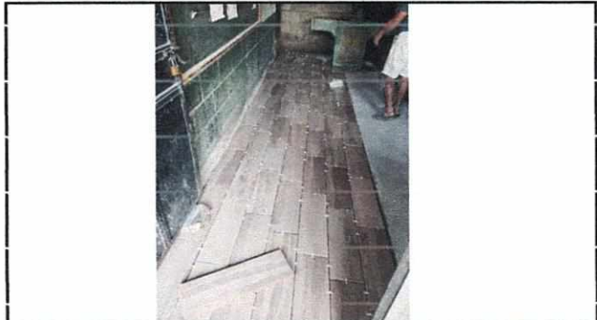
Foto 2: Colocación de Piso
