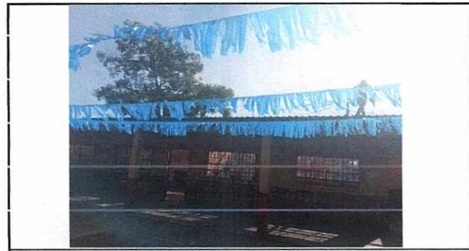
Foto 6: Colocación de Lamina
