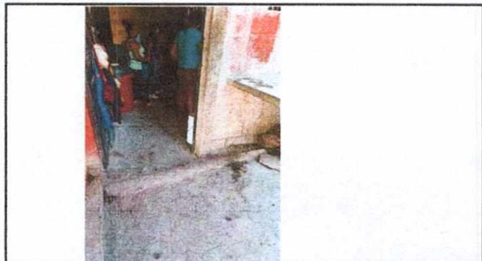
FOTO No.04 Instalacion de piso antiadherente
