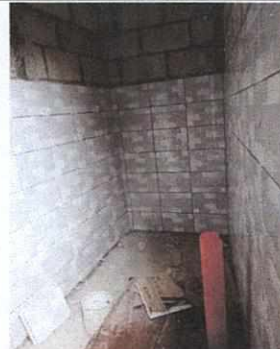
FOTO 4 AMPLIACIÓN DE SERVICIOS SANITARIOS
