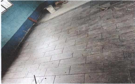
FOTO NO. 3 SUSTITUCIÓN DE PISO
