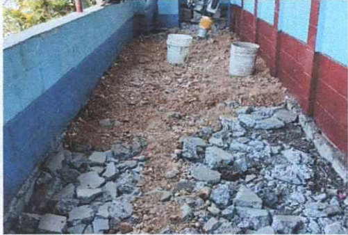
FOTO NO. 1 REPARACIÓN DE MURO DE CORREDOR
