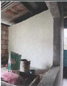
FOTO NO. 5 AMPLIACIÓN DE COCINA
