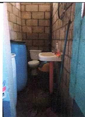
FOTO No.04 Ampliacion de servicios sanitarios
