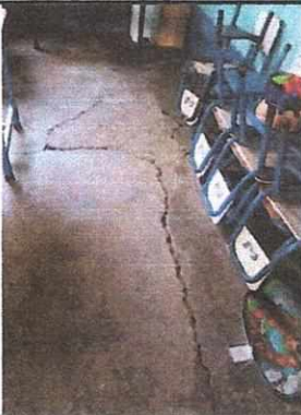
FOTO No. 03 Sustitucion de piso
