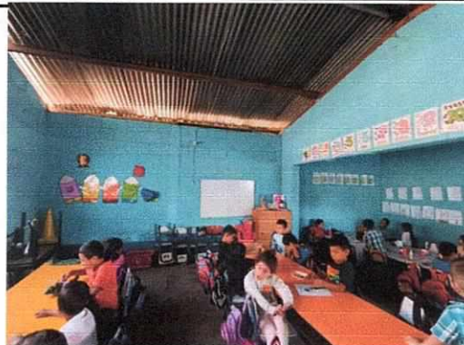
FOTO No.02 Ampliacion de aula
