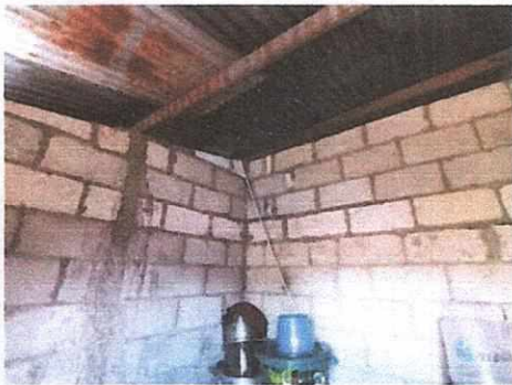
FOTOS No. 05 Ampliacion y reparacion de cocina
