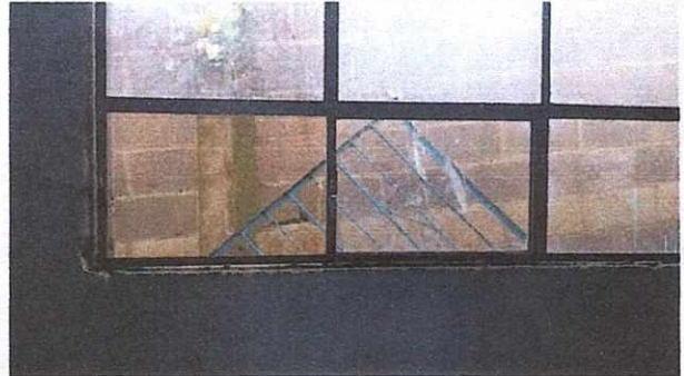
FOTOS No. 06 Reparacion de ventanas
