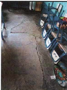
FOTO No. 03 Sustitucion de piso
