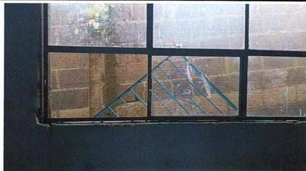
FOTOS No. 06 Reparacion de ventanas
