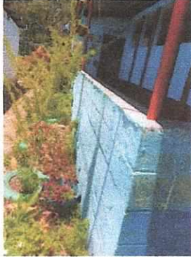
FOTO No. Reparacion de muro del corredor
