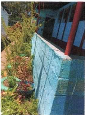
FOTO No. Reparacion de muro del corredor
