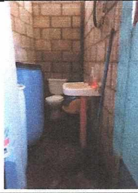
FOTO No.04 Ampliacion de servicios sanitarios
