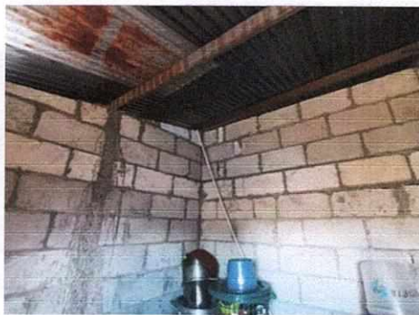
FOTOS No. 05 Ampliacion y reparacion de cocina
