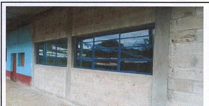
Foto 5: Colocación de ventanas en el salón de clases.
