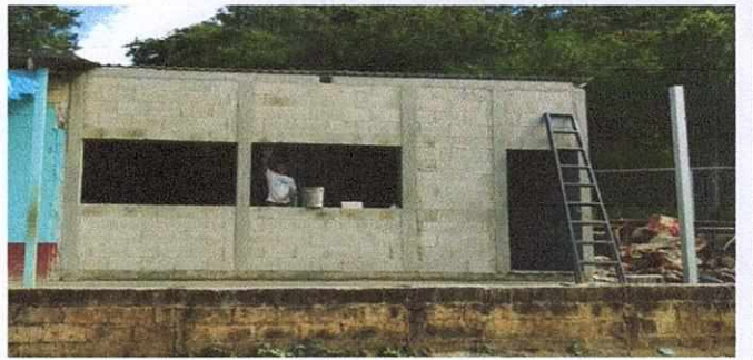
Foto 6: Tallado de columnas y ventanas
