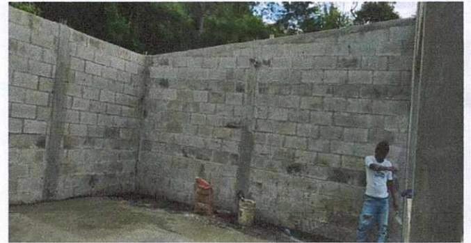
Foto 4: Proceso de fundición de columnas
