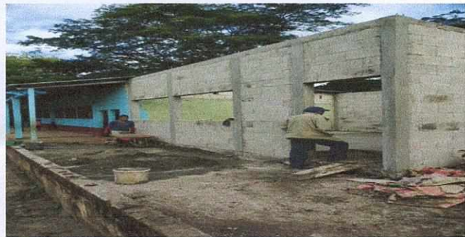
Foto 3: Proceso de construcción de paredes
