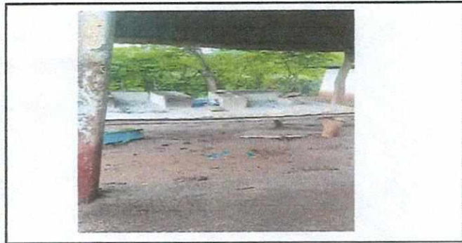
FOTO No. 5 Cocina sin paredes
