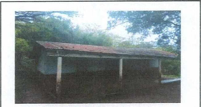
FOTO No.4 sustitución de paredes
