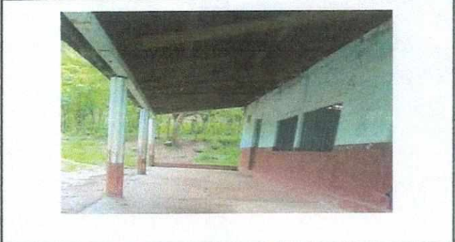
FOTO No. 2 Techo del corredor
