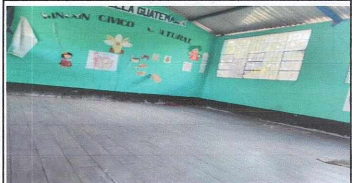
Foto 4: Piso del salón 2
