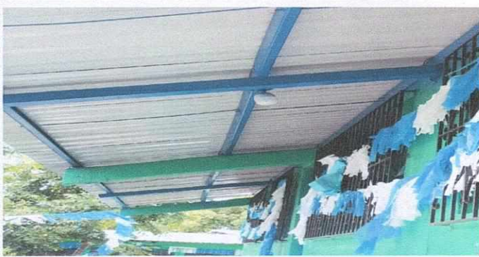
Foto 1: Nuevo techo afuera, parte frontal de los salones
