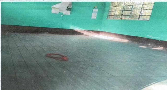
Foto 3: Piso del salón 1
