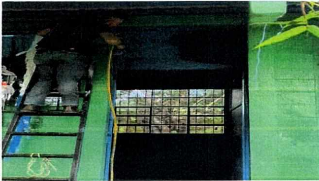
Foto 3: Aplicación de pintura en puertas
