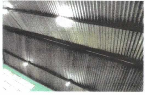
FOTO No. 2 Techo de Lámina
