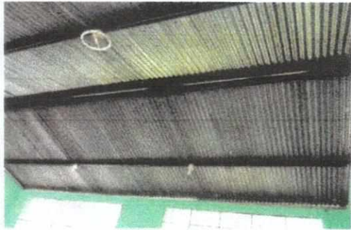
FOTO No. 1 Techo de lámina
