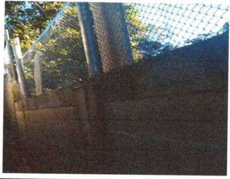
Foto 4: Finalización de muro perimetral
