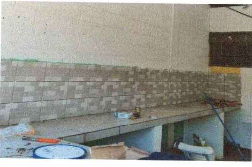
Foto 3: Finalización de mesa fundida de cocina
