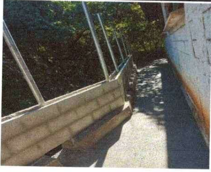
Foto 1: Finalización de entortado
