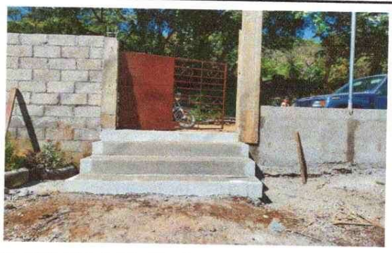
Foto 2: Finalización de gradas
