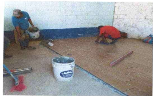
Foto 6: Colocación de piso cerámico en salon de clase
