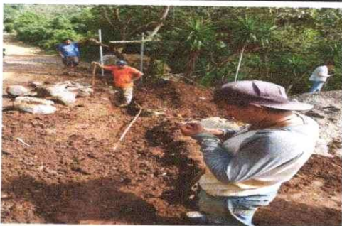
Foto 5: Inicio de muro frontal
