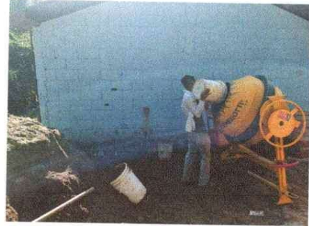
Foto 2: Preparación mezcla para colocación de block
