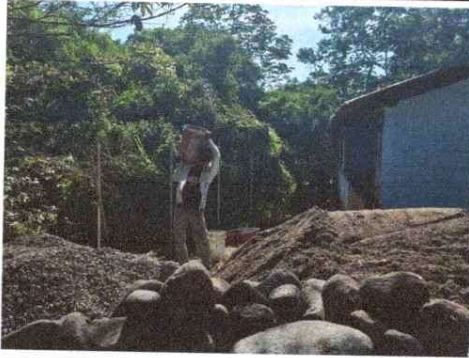
Foto 1: Continuación de levantamiento de muro perimetral
