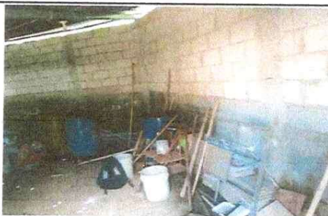
sustitución de baños labables
