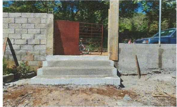
Foto 2: Finalización de gradas
