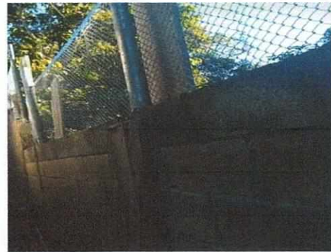
Foto 4: Finalización de muro perimetral
