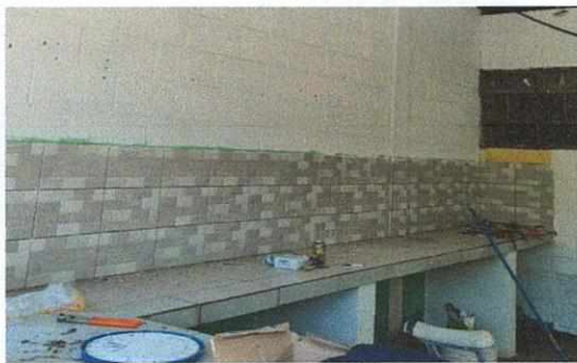
Foto 3: Finalización de mesa fundida de cocina
