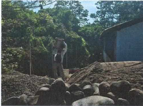
Foto 1: Continuación de levantamiento de muro perimetral
