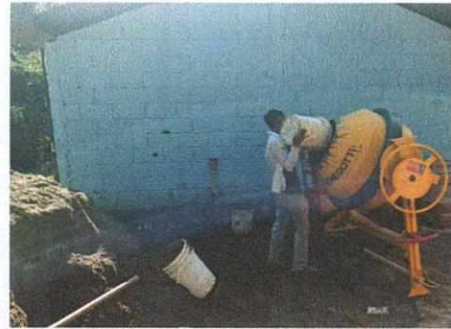
Foto 2: Preparación mezcla para colocación de block
