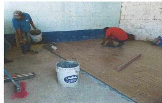
Foto 6: Colocación de piso cerámico en salón de clase
