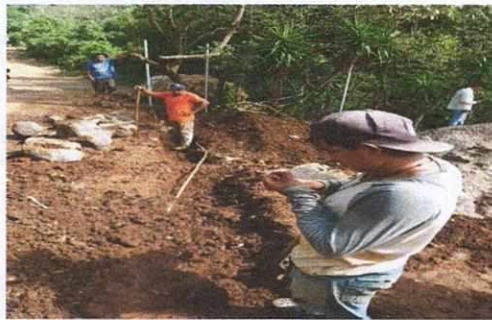
Foto 5: Inicio de muro frontal
