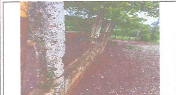
Foto 3: Muro perimetral, parte frontal dañada y malla en pesimas condiciones
