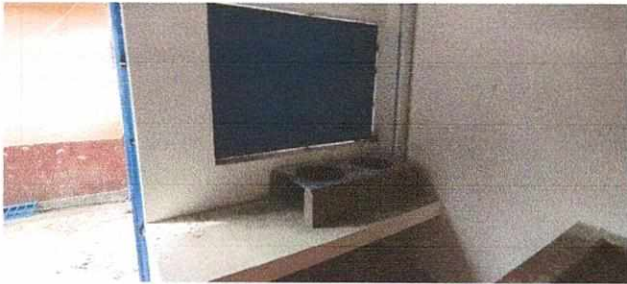
FOTO No. 03 INSTACION DE MESA PARA SERVIR ALIMENTOS Y PLANCHA PARA COCINA
