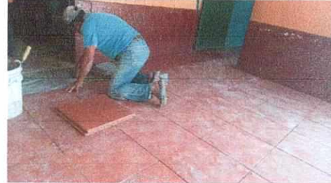
FOTO No.02 INSTALACION DE PISO EN CORREDOR
