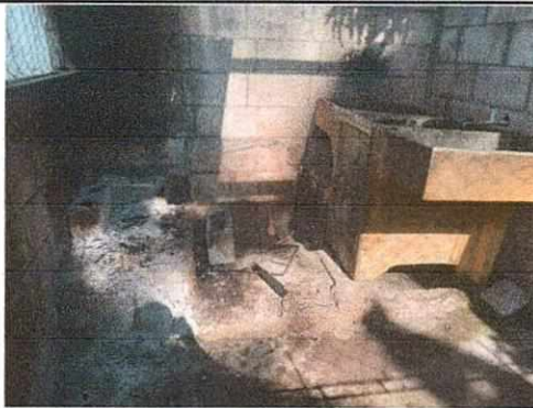
FOTO No.02 INTALACION DE PLANCHA mas CHIMENEA EN COCINA
