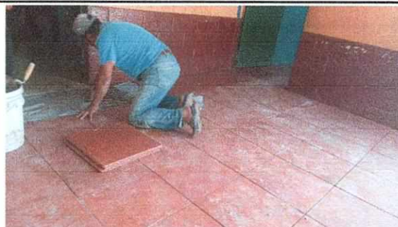
FOTO No.04 SUSTITUCION DE PISO DE GRANITO POR PISO CERAMICO EN CORREDOR
