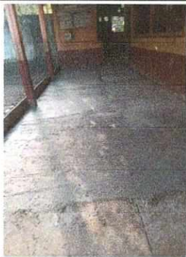
FOTO No. 01 SUSTITUCION DE LOSA POR PISO CERAMICO
