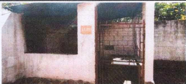
Foto No. 03 Implementacion de puerta metalica y ventana metalica
