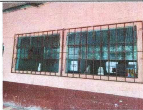
Foto No.02 Reparacion de balcones
