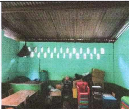
Foto No. 01 Reparacion de paredes
