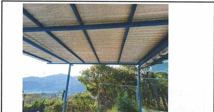
FOTO No.02 SUSTITUCION DE TECHO DE CORREDOR
