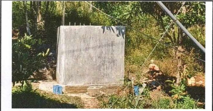
FOTO No. 01 REFORZAMIENTO DE SISTERNA
