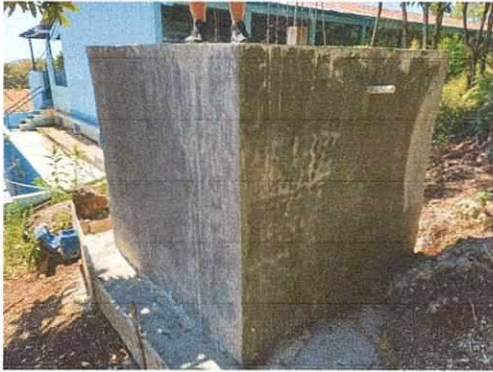
FOTO No. 01 REFORZAMIENTO DE SISTERNA
