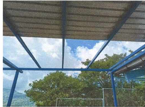
FOTO No.02 SUSTITUCION DE TECHO DE CORREDOR
