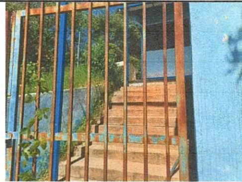
FOTO No.04 SUSTITUCION DE PORTONES
