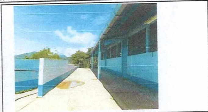
FOTO No. 01 Instalacion de estructura metalica
