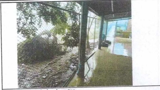
FOTO No.02 Instalacion de porton
