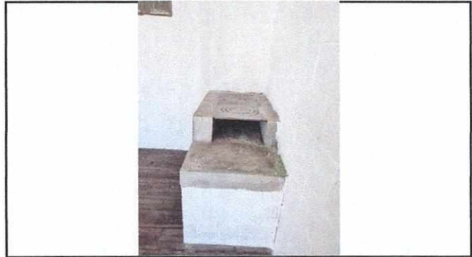
FOTO 2 ELABORACIÓN DE COCINA CON CHIMENEA
