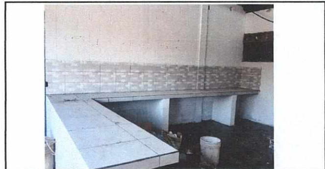
FOTO 6 CONSTRUCCIÓN MESA DE CONCRETO
