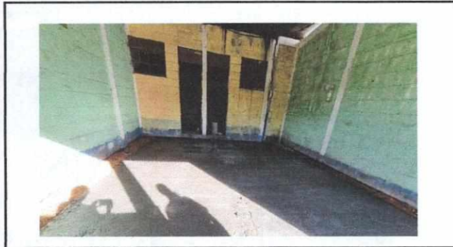
FOTO 3 FUNDICIÓN DE TORTA DE CEMENTO
