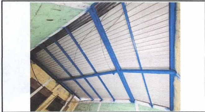
FOTO 1 REPARACIÓN DE LÁMINA
