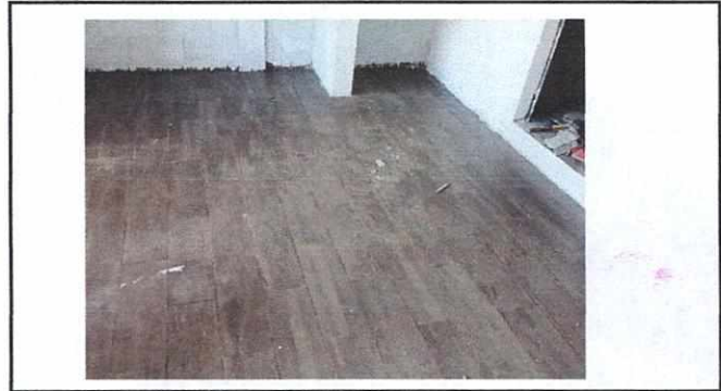
FOTO 4 INSTALACIÓN DE PISO CERAMICO
