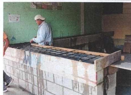
FOTO 6 CONSTRUCCIÓN DE MESA DE CONCRETO
