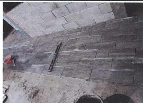
FOTO 4 INSTALACIÓN DE PISO CERAMICO
