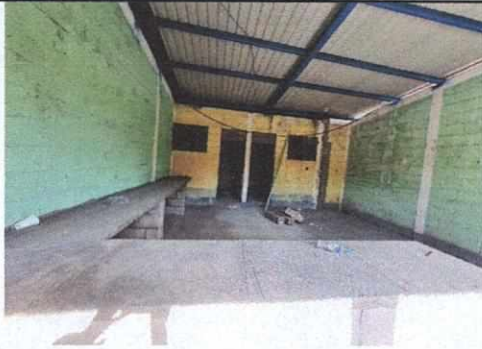
FOTO 1 REPARACIÓN DE LÁMINA
