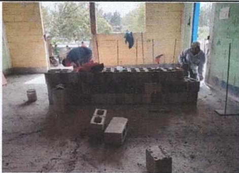
FOTO 5 COLOCACIÓN DE VENTANA EN COCINA
