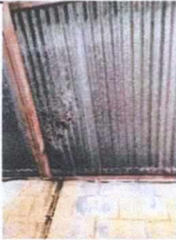
FOTO No. 05 Reparacion de pared de aula
