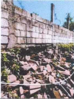
FOTO No. 01 Reparacion muro perimetral
