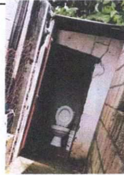
FOTO No.04 Reparacion de servicios sanitarios
