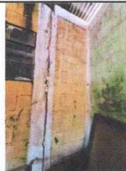
FOTO No. 06 Reparacion de pared de aula
