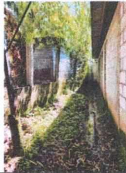
FOTO No. 02 Reparacion muro perimetral
