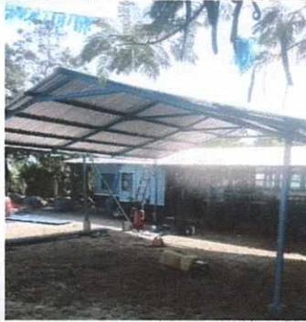
FOTO No.01 INSTALACION DE TECHO Y ESTRUCTURA METALICA EN PATIO
