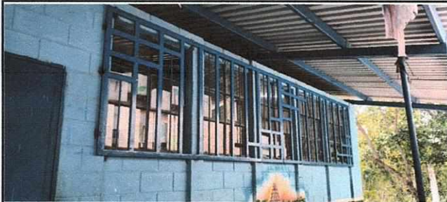
FOTO No. 03 SUSTITUCION DE BALCONES EN AULAS
