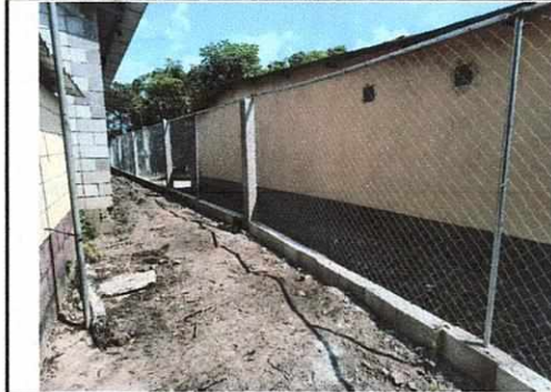
FOTO No. 02 SUSTITUCION DE MALLA METALICA Y TUBO GALBANIZADO
