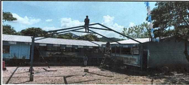
FOTO No. 01 INSTALACION DE TECHO Y ESTRUCTURA METALICA EN PATIO
