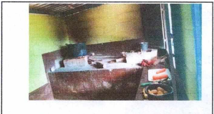
FOTO No. 05 Cocina sustitucion de piso antiadherente
