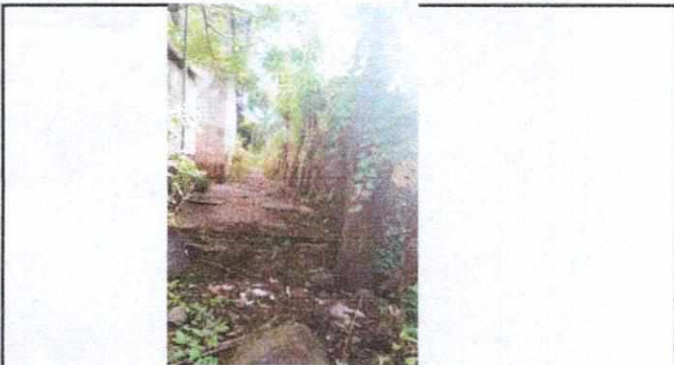
FOTO No. 04 Reparacion de fosa septica
