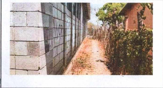
FOTO No.1 MURO PERIMETRAL
