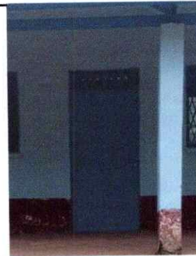
Foto 6: Cambio de puertas
