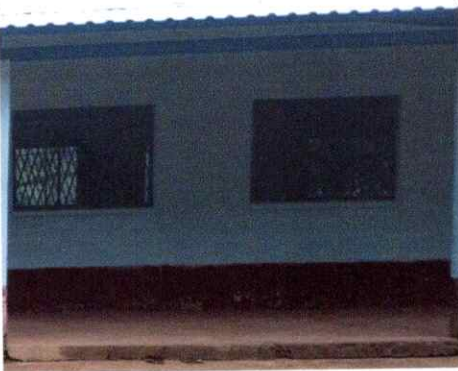
Foto 3: Sustrucion de balcones y cedaso
