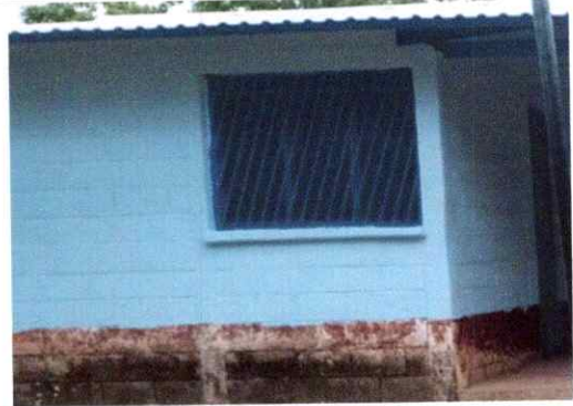
Foto 4: Sustrucion de balcones y cedaso
