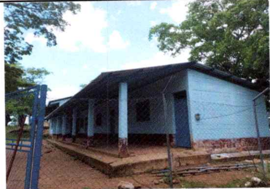
Foto 2: Sustrucion de techo
