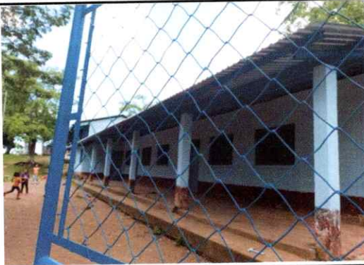
Foto 1: Sustrucion de techo
