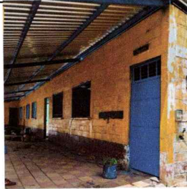
Foto 2: Sustitucion de techo
