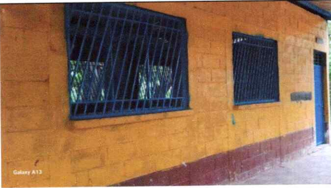
Foto 3: Sustitucion de balcones y cedaso
