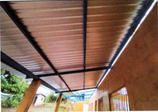
Foto 1: Sustitucion de techo
