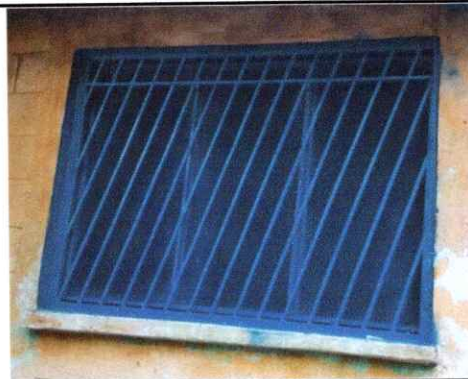
Foto 4: Sustitucion de balcones y cedaso
