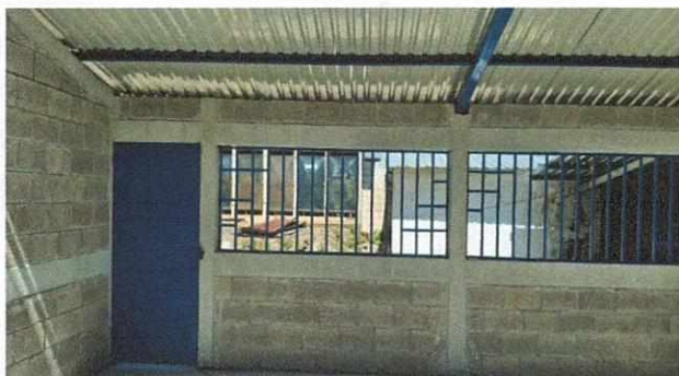
FOTO NO. 3 INSTALACION DE TECHO EN AULA
