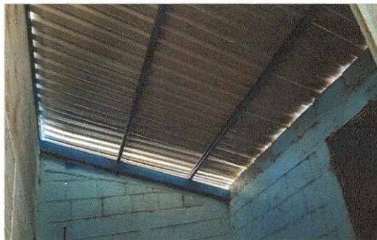
FOTO NO. 4 INSTALACION DE TECHO DE DIRECCIÓN DEL ESTABLECIMIENTO
