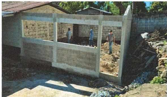
FOTO NO. 1 PAREDES RECONSTRUIDAS DE AULA
