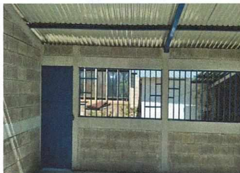
FOTO NO. 2 INSTALACIÓN DE PUERTAS Y BALCONES EN AULA
