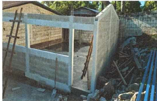
FOTO NO. 02 RECONSTRUCCIÓN DE PISO DE AULA
