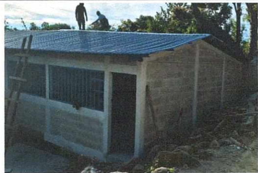
FOTO NO. 04 INSTALACIÓN DE TECHO EN AULA
