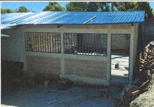
FOTO No. 03 INSTALACION Y PINTURA DE BALCONES INCRUSTRADOS EN MARCO
