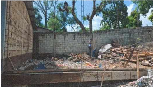
FOTO NO. 1 RECONSTRUCCIÓN DE PAREDES DE AULA
