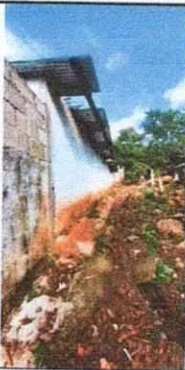
FOTO No. 03 Ampliacion de una pared
