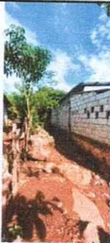
FOTO No.05 Sustitucion de muro perimetral
