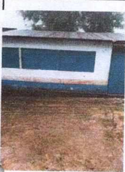
FOTO No. 1 Aula reparacion de paredes
