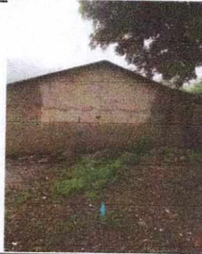
FOTO No.1 Aula reparacion de paredes
