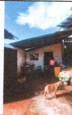
FOTO No.04 Levantamiento de pared, techo y sustitucion de piso antiaherente
