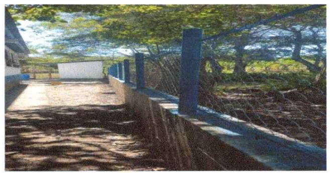
Foto 4: INSTALCION DE MURO Y MALLA PERIMETRAL
