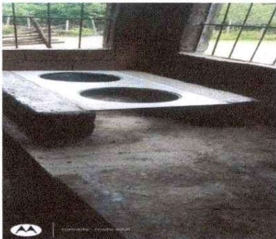
Foto 3: MESA DE CONCRETO Y COLOCACIÓN DE PLANCHA
