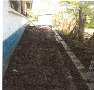
Foto 2: INICIA DE MURO PERIMETRAL LEVANTAMIENTO DE BLOCK
