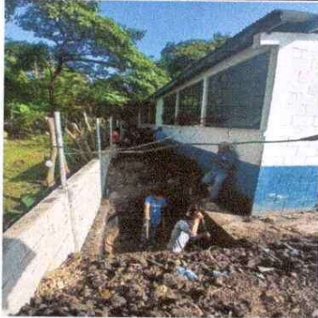
Foto 1: HACIENDO ESCABACION DE POZO PARA FOSA SEPTICA
