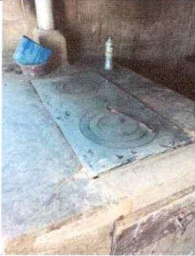
FOTO No.01 INSTALACION DE PLANCHA PARA COCINA
