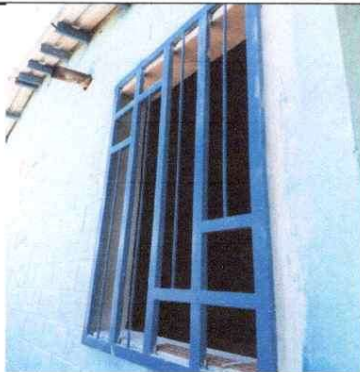
FOTO No.03 INSTALACION DE VENTANA E INSTALACION DE BALCON DE METAL
