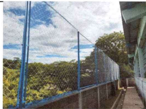
FOTO No.04 SUSTITUCION DE MALLA METALICA CON TUBO GALVANIZADO
