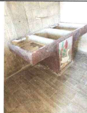
FOTO NO. 02 INSTALACION DE PILA LAVABLE DE CONCRETO
