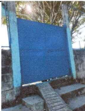
FOTO No.05 SUSTITUCION DE PORTON DE METAL
