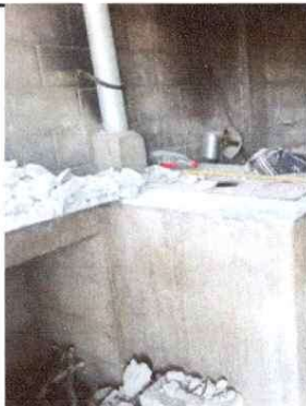
FOTO No.3 Sustitucion de plancha
