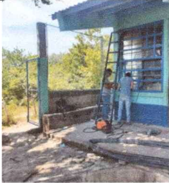
FOTO No. 01 Sustitucion de balcones
