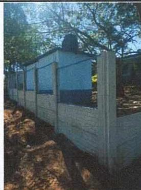
FOTO No.02 INSTALACION DE MALLA METALICA SOBRE MURO
