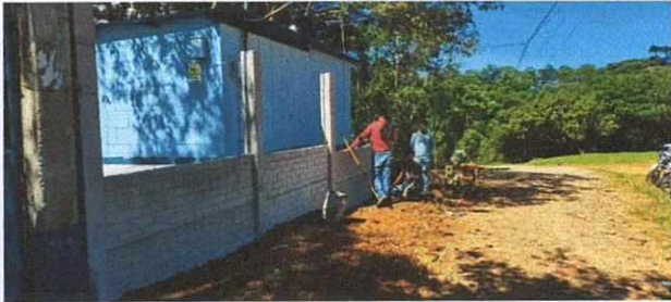
FOTO No.01 INSTALACION DE MURO PREFABRICADO CON MALLA METALICA
