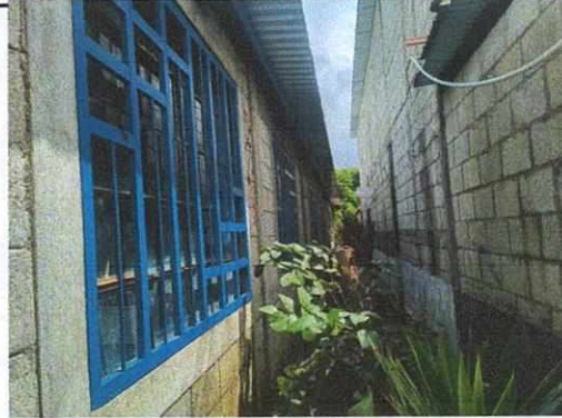
FOTO No.02 INSTALACIONES DE BALCONES
