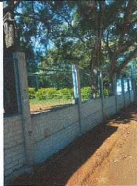
FOTO No.04 INSTALACION DE MALLA METALICA
