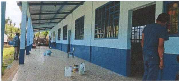
FOTO No.03 INSTALACION Y PINTURA DE BALCONES INCRUSTRADOS EN MARCO
