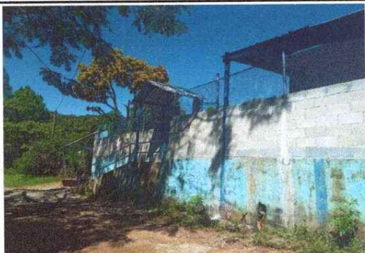
Foto 1: Muro perimetral parte exterior
