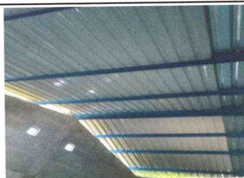
Foto 6: Techo de lámina
