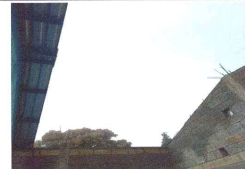
Foto 6: Instalación de techo de lámina
