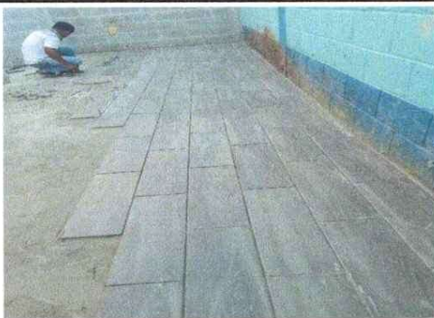
Foto 5: Instalación de Piso
