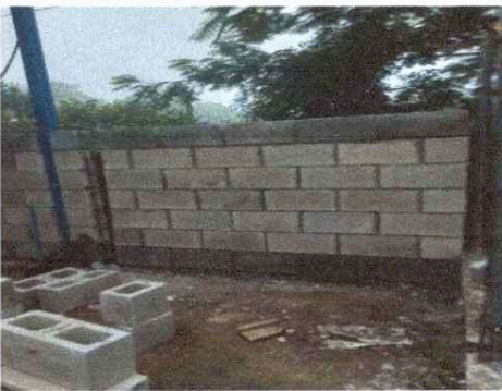
Foto 3: Levantamiento con block con altura normal
