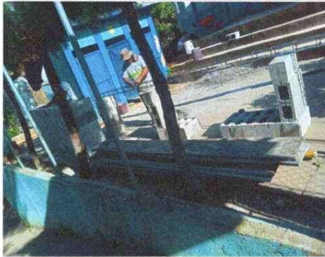
Foto 1: Realización de soleras
