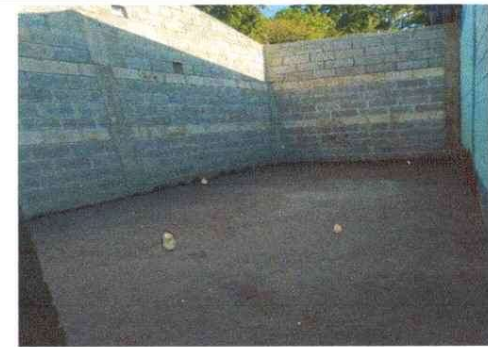
Foto 4: Fundición de base para piso
