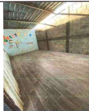
Foto 6: salon con piso y pared terminada
