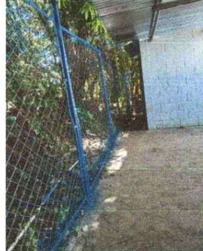
Foto 2: Malla Perimetral Instalada
