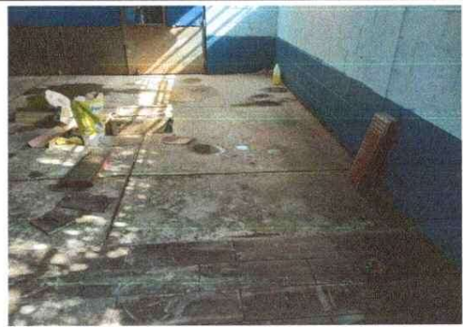
Foto 4: Instalación de piso
