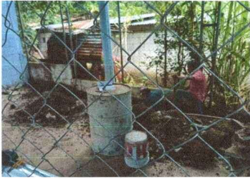
Foto 1: construcción de pared
