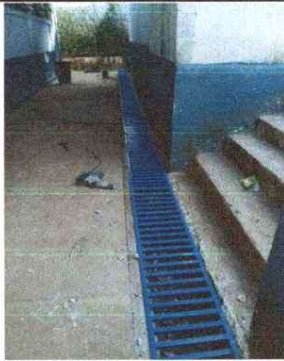
Foto 3: Instalación de Rejillas en Cunetas
