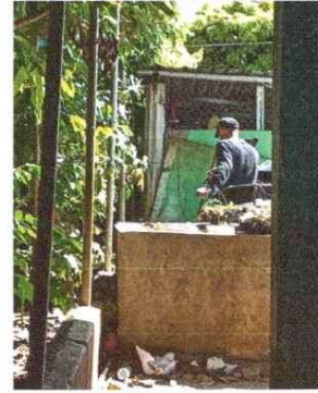
Foto 2: Reparación de Malla perimetral
