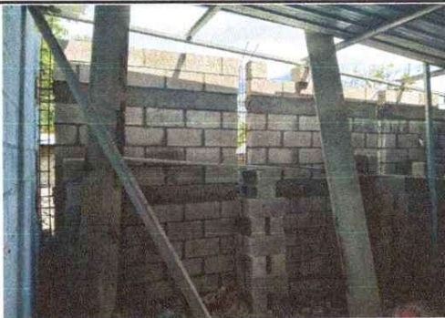
Foto 5: Construcción de pared de block
