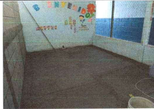
Foto 6: instalación de torta y piso
