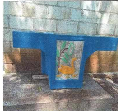
FOTO No. 04 INSTALACION DE PILA DE CONCRETA
