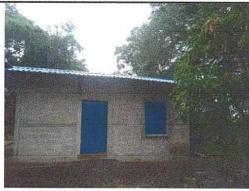
FOTO No. INSTALACION DE TECHO, VENTANA Y PUERTA METALICA
