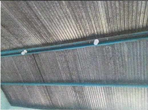
FOTO No.03 INTRODUCCION DE ENERGIA ELECTRICA EN AULAS
