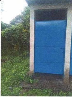
FOTO No.1 INSTALACION DE PUERTA METALICA EN BAÑOS
