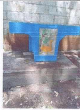
FOTO No.02 INSTALACION DE PILA DE CONCRETO
