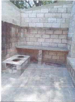
FOTO No. 01 SUSTITUCION DE PISO EN COCINA
