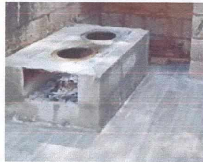
FOTO No.04 INSTALACION DE PLANCHA EN COCINA
